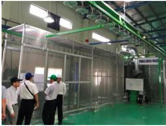
写真 3.5.5 粉体塗装設備
