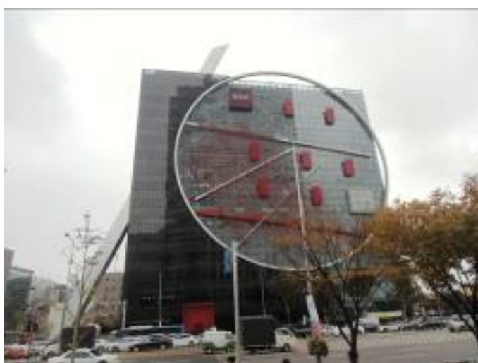
写真 3.3.1 現代産業開発本社の全景
