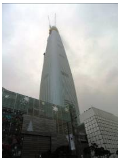
写真 3.3.4 第2 ロッテワールド
