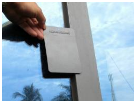
写真 3.6.4 色調見本板との確認 (外部)
