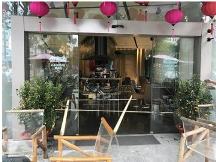
写真 3.6.11 Pullman Saigon Centre Hotel ドア枠パネル
